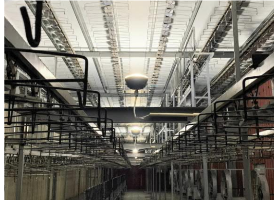
THTの高温照明器具の応用事例で、設置環境が80°C以上の高温環境下のスルメ乾燥工場です。
